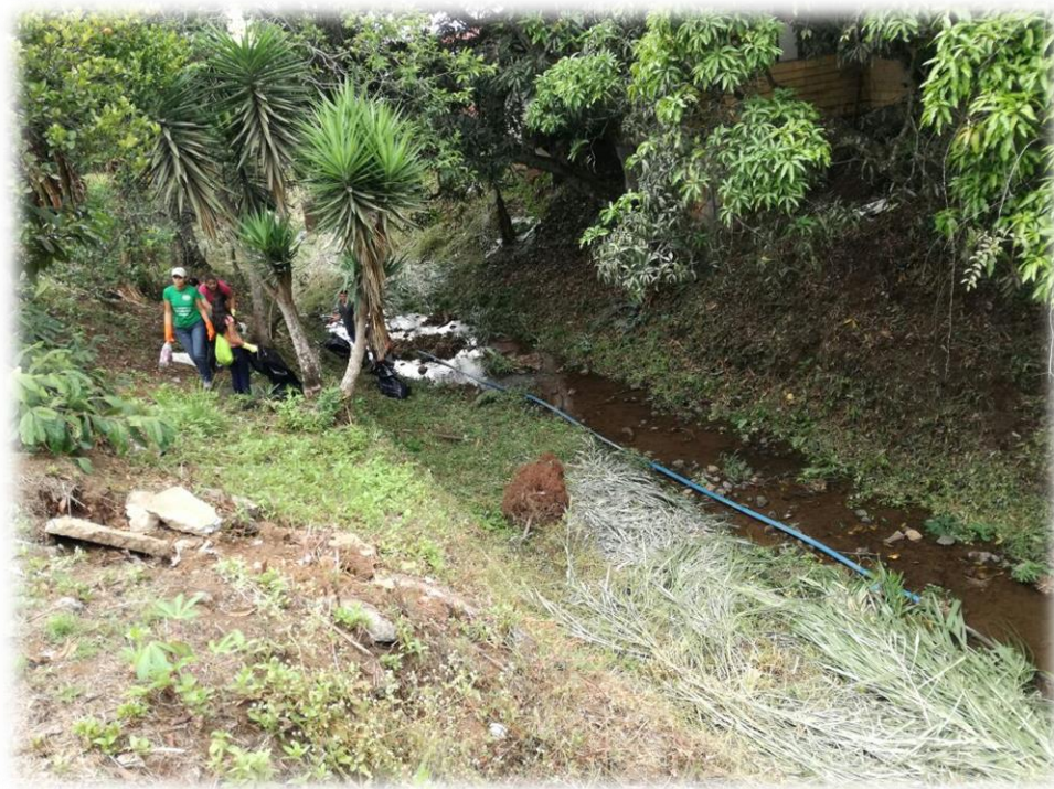
Imagen 8. Trabajo en la Quebrada
