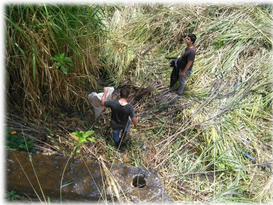
Imagen 7. Trabajo en la Quebrada
